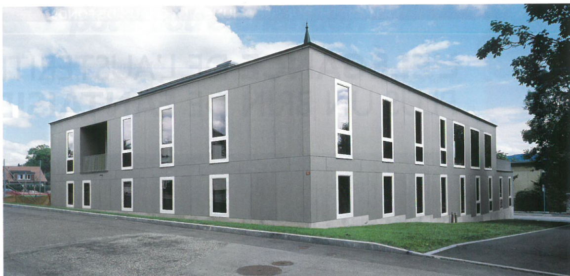
Vue arrière du bâtiment.
