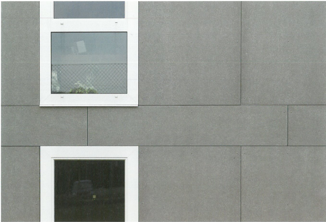
Les fenêtres métalliques régnant avec le nu extérieur soulignent l'aspect massif de l'habillage des façades.
