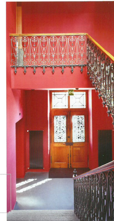
L'ancien escalier retrouvé et restauré.
