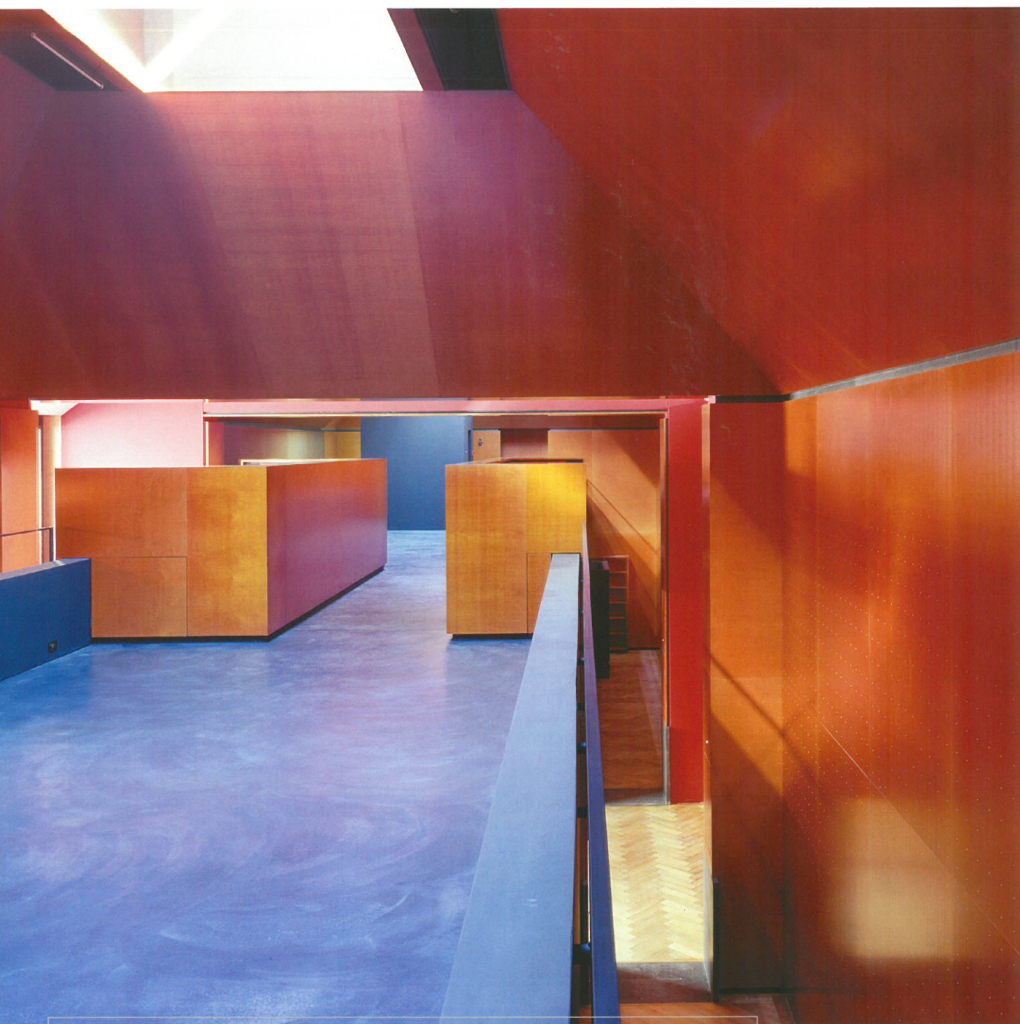
La générosité des volumes originaux a permis la construction de mezzanines, espaces d'expositions temporaires. La pré perforation des revêtements en bois sert de système simple et modulaire de fixation d'objets ou de tableaux.
