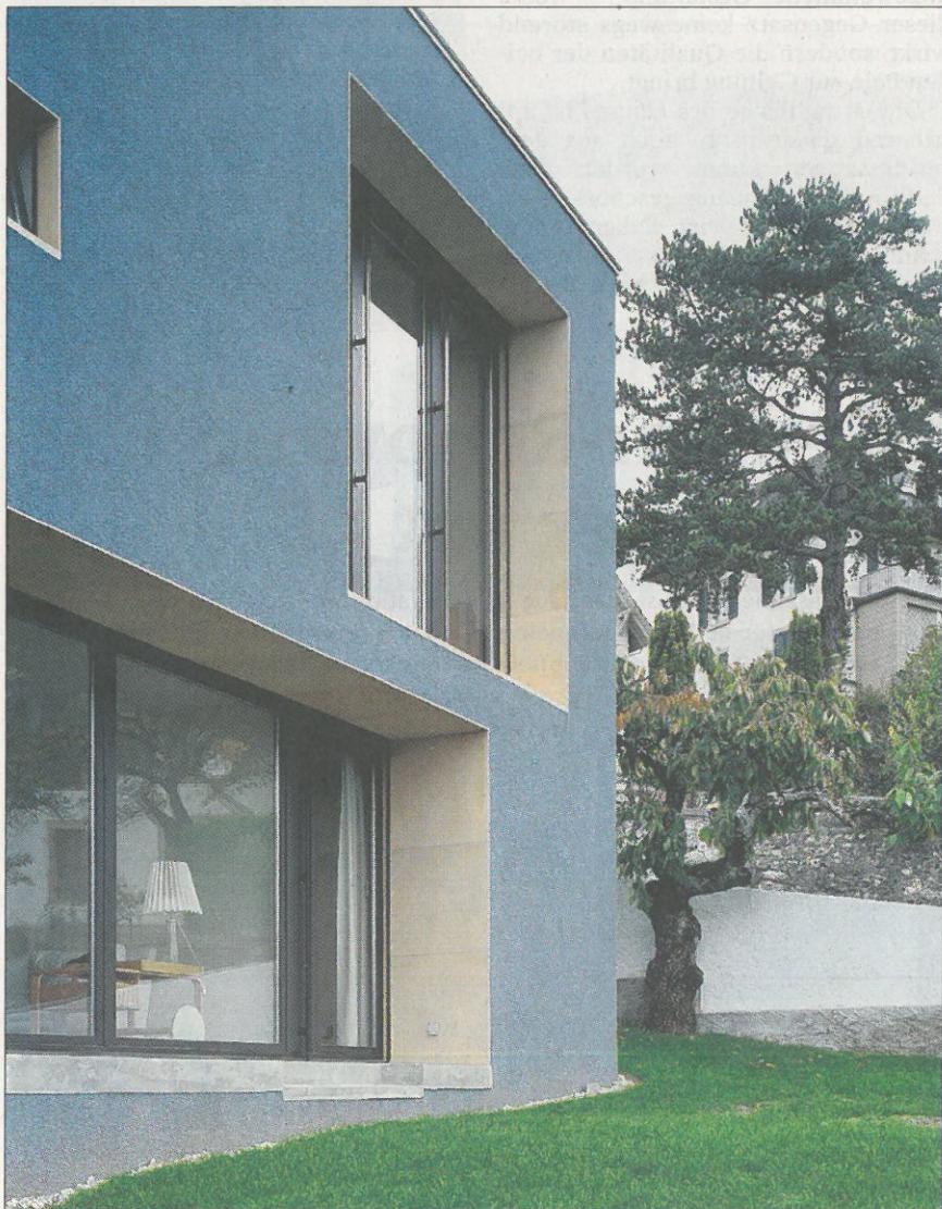
Der gelbe Stein der Fensterlaibungen ist in Neuenburg verbreitet. (Thomas Jantscher)
