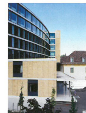
13 Nouvel Hôpital Pourtalès Standort: rue de la Maladière 45 Bauherrschaft: Ville de Neuchâtel Architekten: Geninasca Delefortrie, R.-E. Monnier, GMS Architectes, Neuchâtel; Projektleitung: Y.-O. Joseph; Mitarbeiter: J.-M. Deicher, Juan Garcia, Etienne Dubois, Line Fontana, Thomas Henking, Marc Tabacchi, Marianne Kienholz Bauingenieur: ICR SA, RBA SA, Cernier Ausführung: 1998–2005
